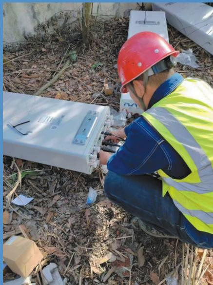
施工队员正在平江长寿四联700M村村通5G站点施工现场进行馈线安装
