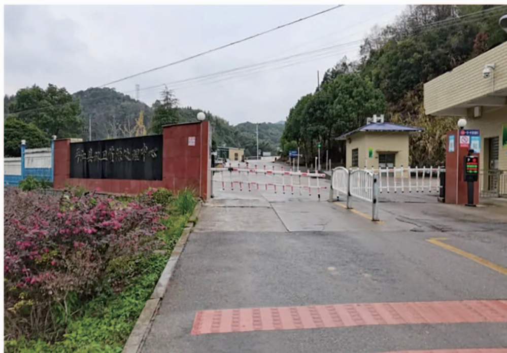
平江县垃圾填埋场整改后干净整洁的大门
